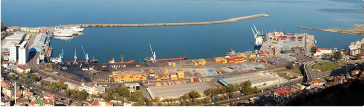
Resim 2. Trabzon Limanı Genel Görünüm
